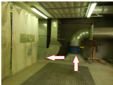
Рис. 49. Вытяжная вентиляция со сменными фильтрами
