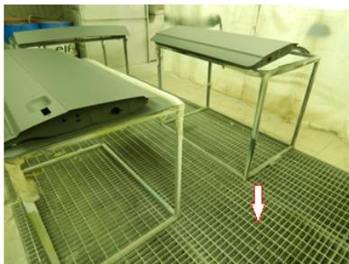
Рис. 48. Вытяжная вентиляция со сменными фильтрами
