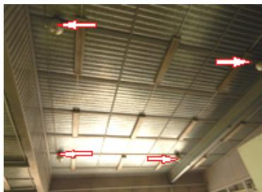
Рис. 57. Потолочная система пожаротушения
