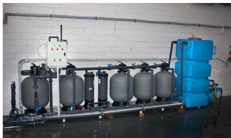
Рис. 55. Система очистки воды для моечных установок АРОС-1 ДК
